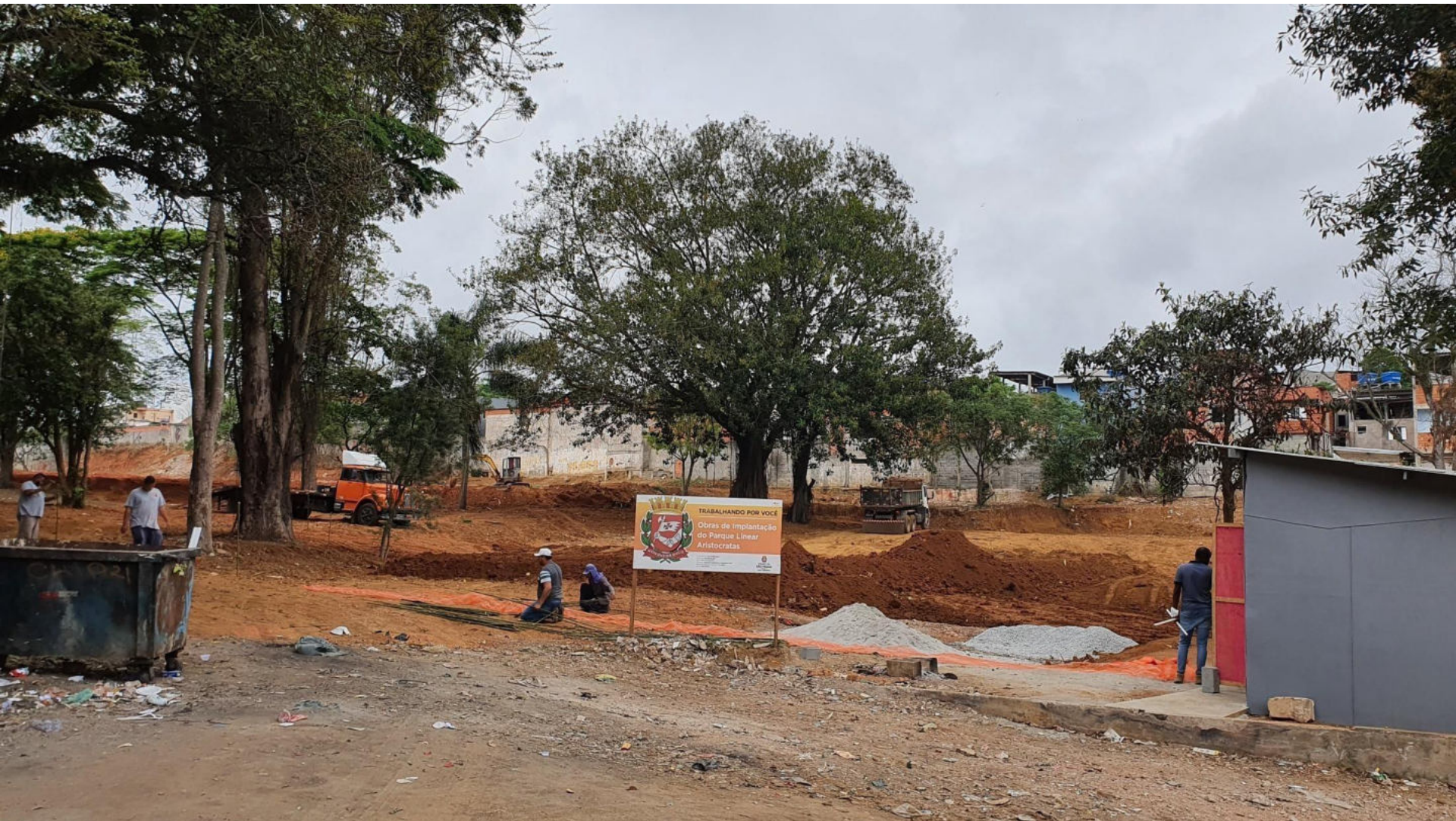
Obras de Implantação em andamento – setembro/2021
